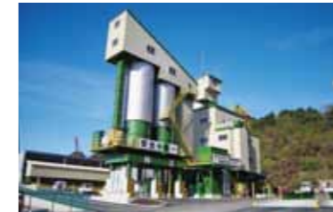
プラントを全閉型のシェルタータイプとし、都市ガスを燃料とする設備を導入し、2011年度に環境整備を図った例:岡崎合材工場
