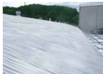
屋根断熱防水施工後状況
