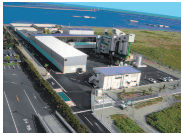
鹿児島合材工場(2007年10月開設)
