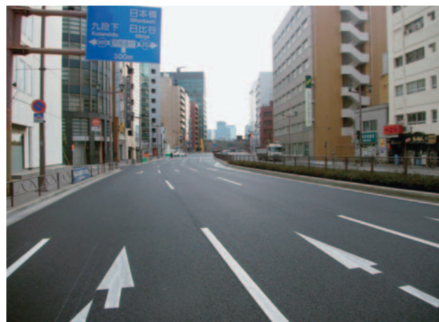
国道20号 麴町舗装修繕工事
