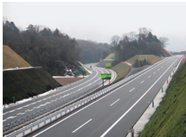
新名神高速道路 大津舗装工事
