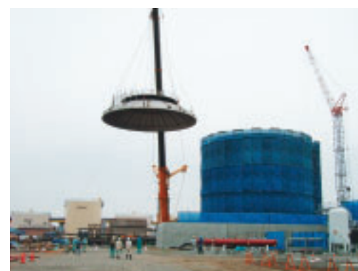
八戸LNG基地建設工事タンク屋根上架
