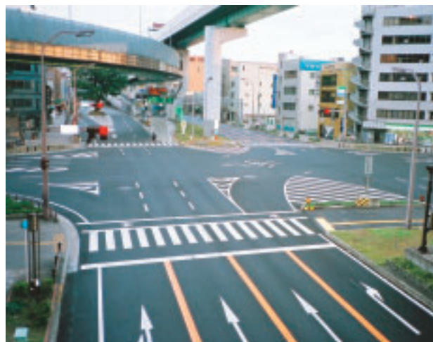
国道41号 泉工事
