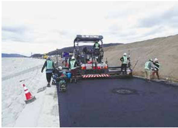
施工状況 (NIPPO提供)
